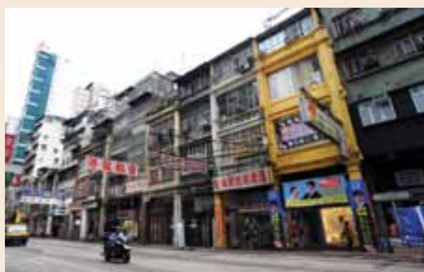
位於太子道西(上)及上海街的两組珍貴的騎樓建築群。
