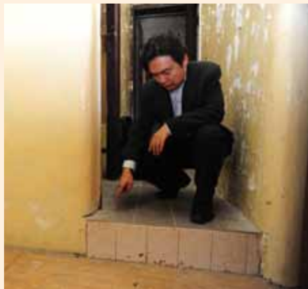
市建局職員檢查樓宇狀況。
