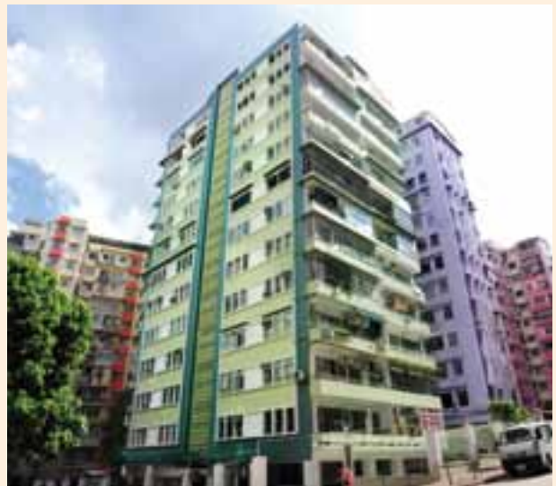
觀塘華豐大廈復修後的新面貌。
