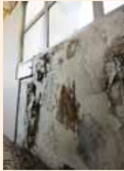
油麻地翠園大廈復修前後的面貌。
